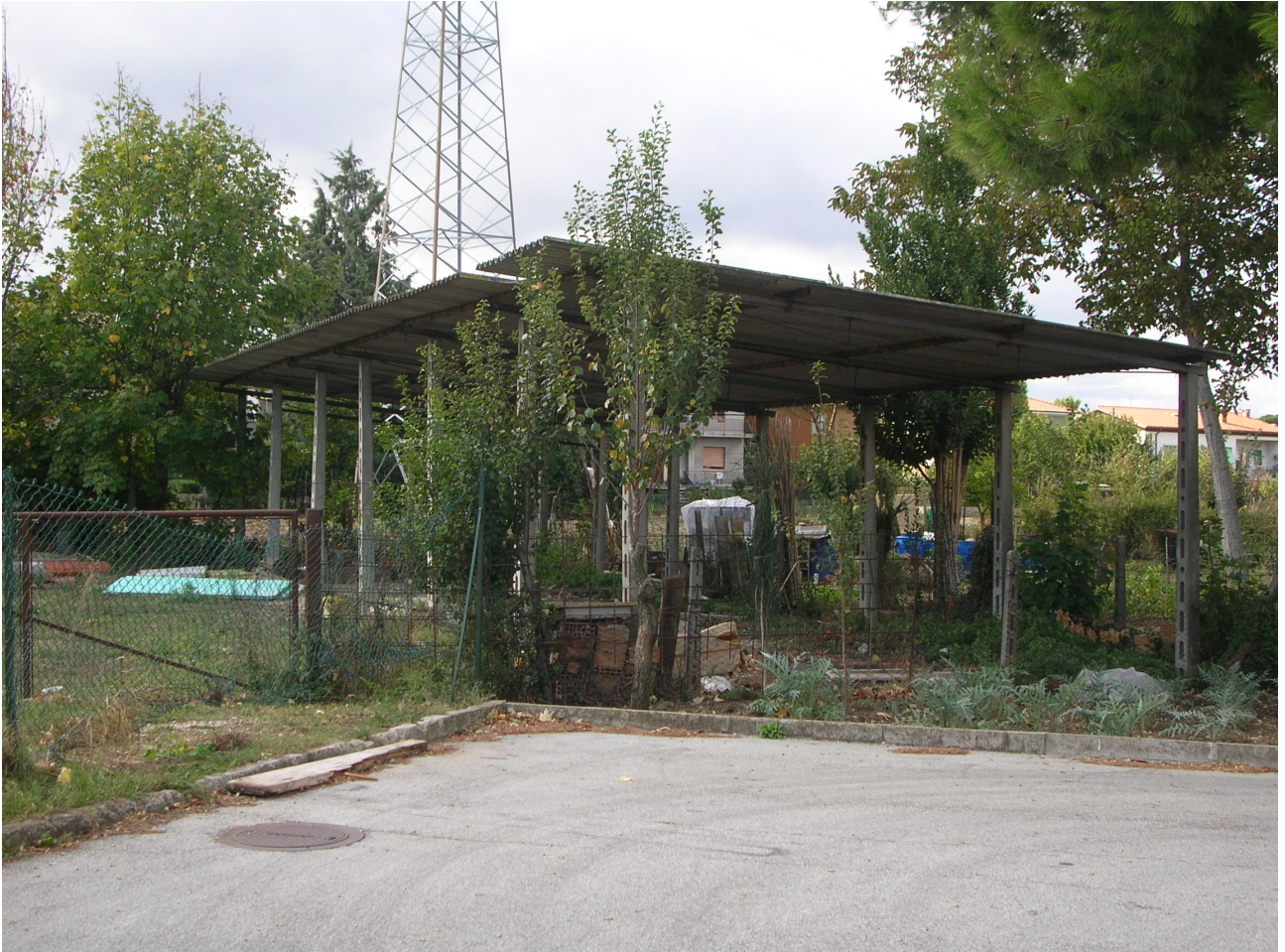
Tettoia da demolire
