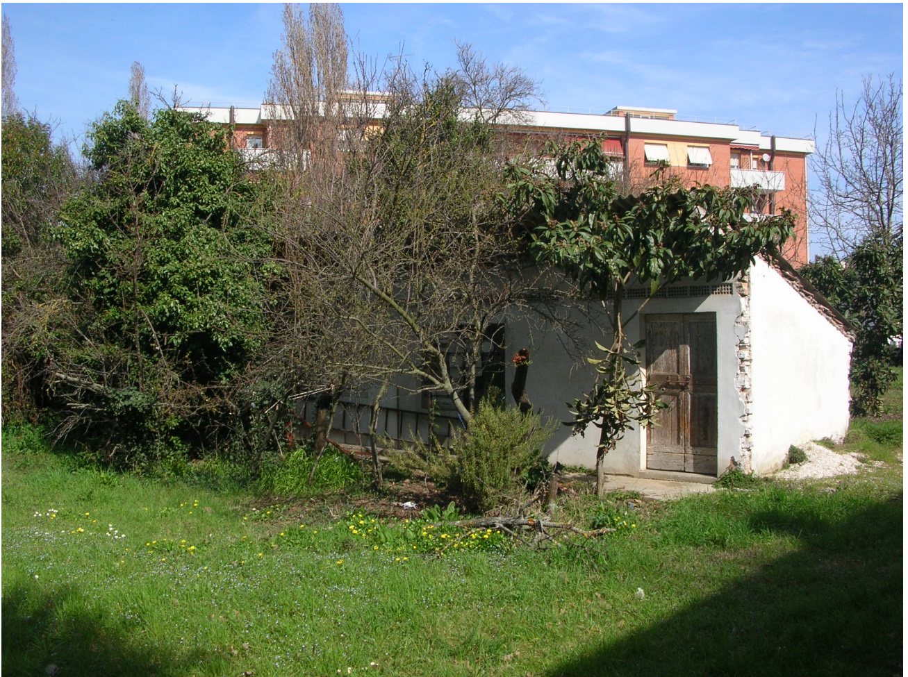
Accessorio da demolire
