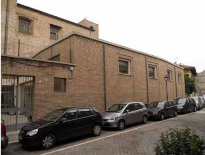
Foto 4- UNITA' EDILIZIA 28 Prospetto Ovest, su via Da Serravalle
