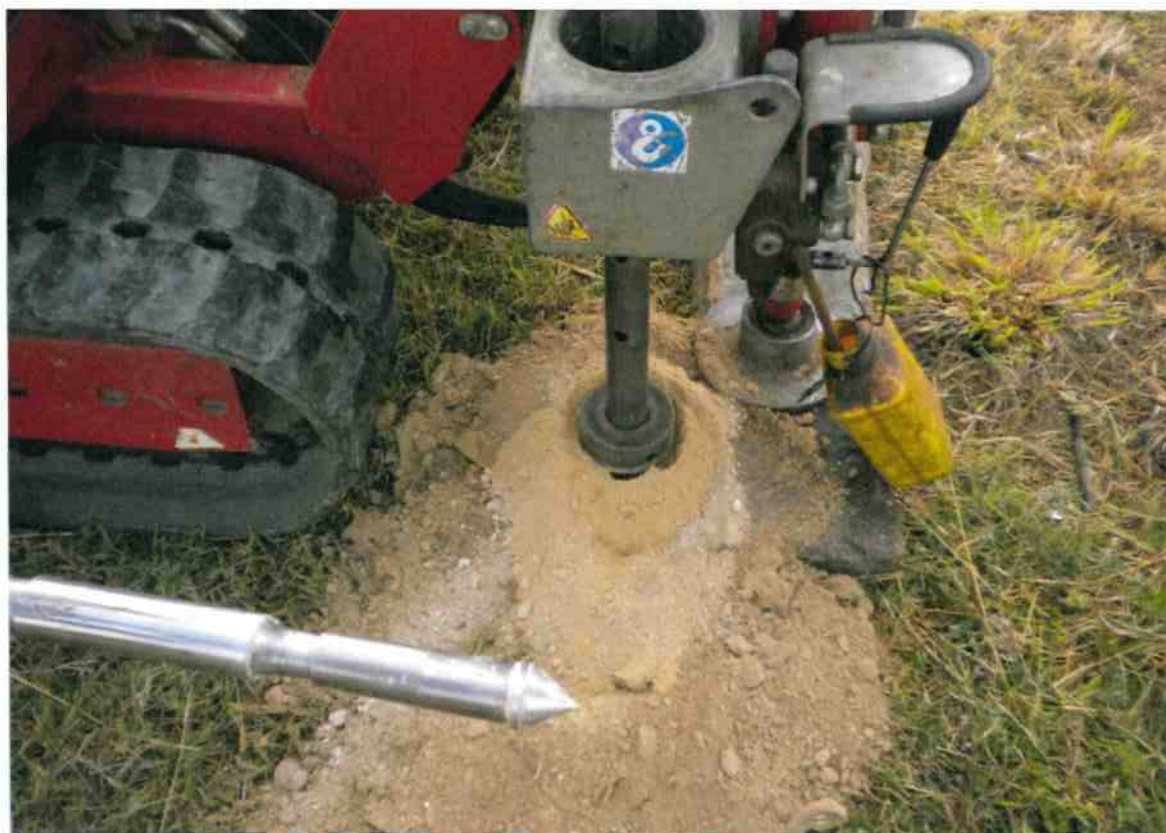
FOTO N.4 – Affioramento della formazione in posto in litofacies sabbioso-arenacea in corrispondenza della prova DPSH n.1, Area "Ristorante Nuova Casaccia" – Loc. Roncosanbaccio – Fano (PU).
