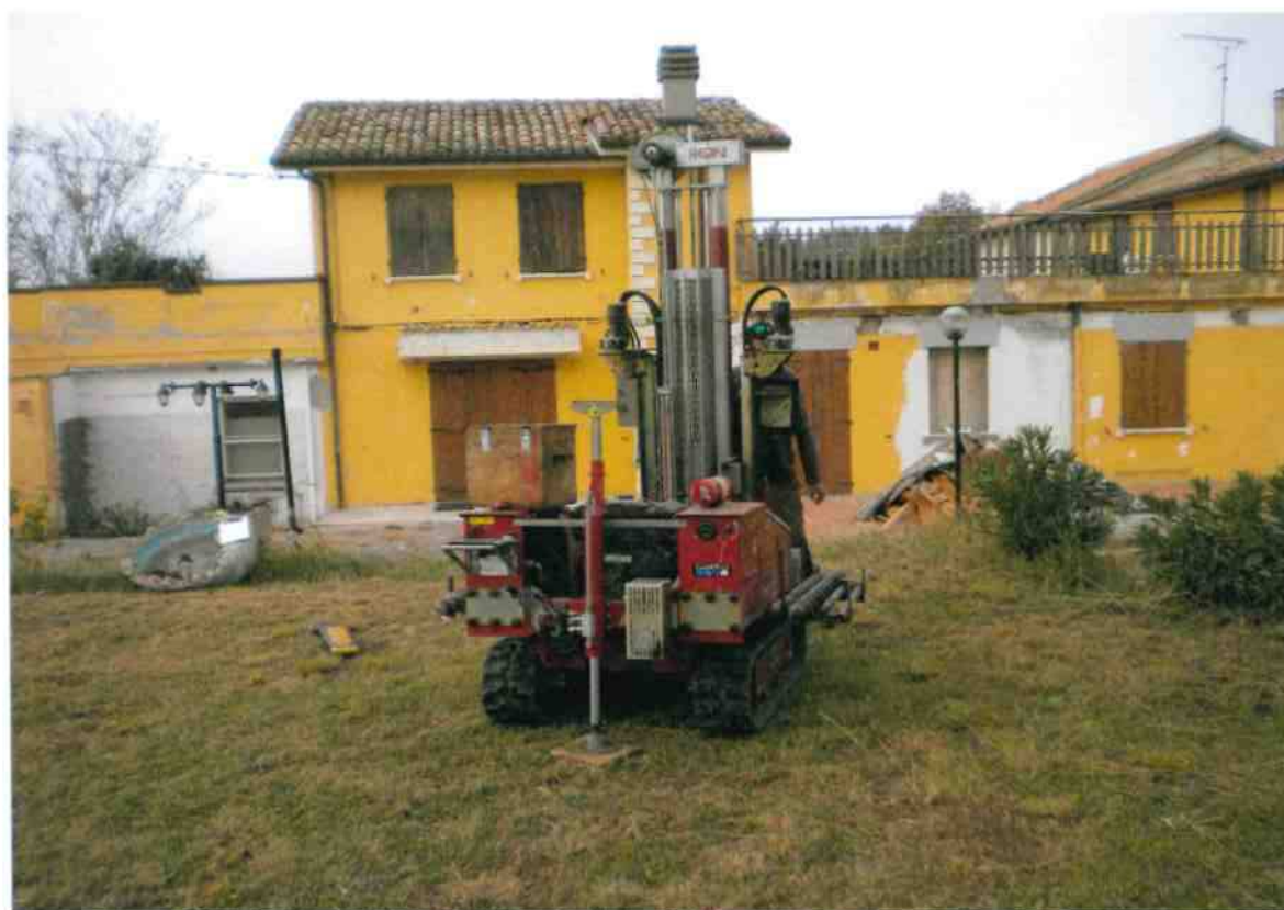
FOTO N.2 – Esecuzione prova penetrometrica dinamica DPSH n.1 – Area "Ristorante Nuova Casaccia" – Loc. Roncosanbaccio – Fano (PU).
