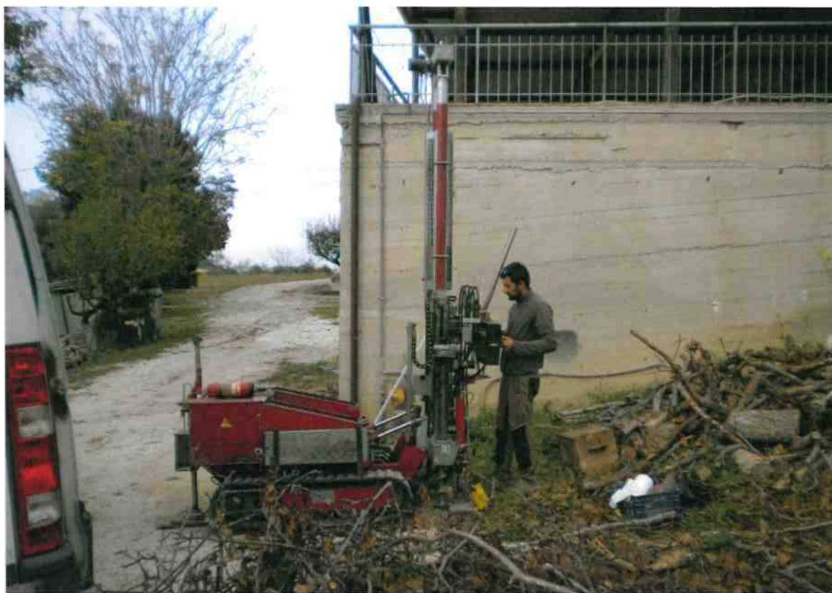
FOTO N.1 – Esecuzione prova penetrometrica statica CPT n.1 – Area "Ristorante Nuova Casaccia" – Loc. Roncosanbaccio – Fano (PU).
