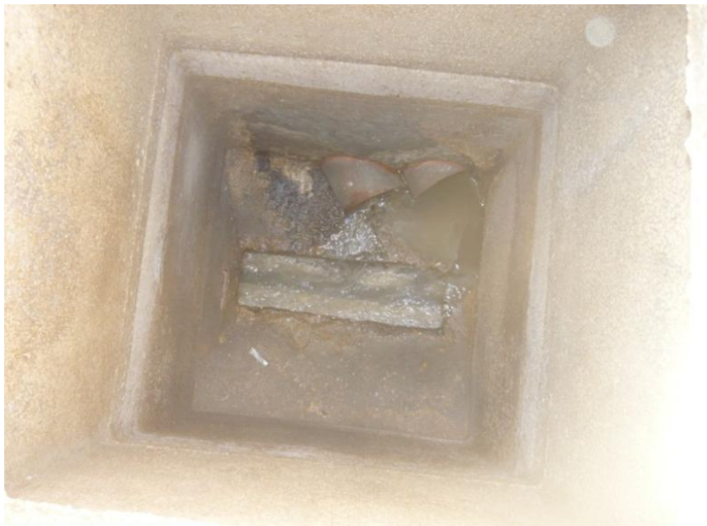
Foto 1 - Apertura pozzetto P15 via del Moletto
